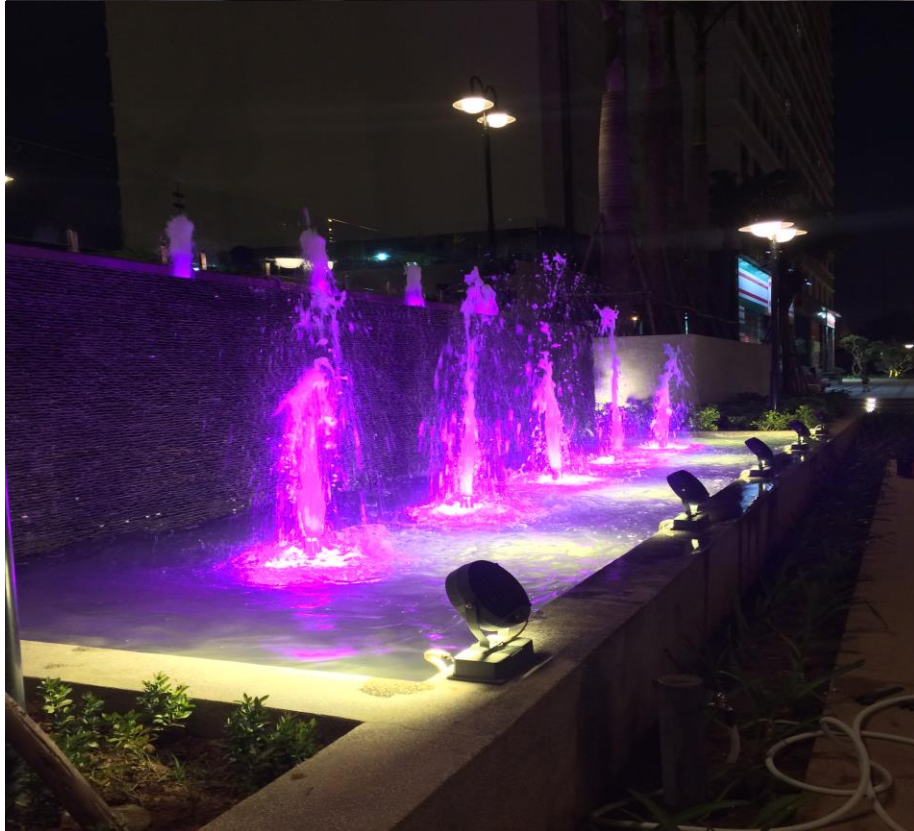
Bể bơi, Đài phun tại chung cư H,J,K – Cụm chung cư CT7 thuộc khu đô thị mới Dương Nội
