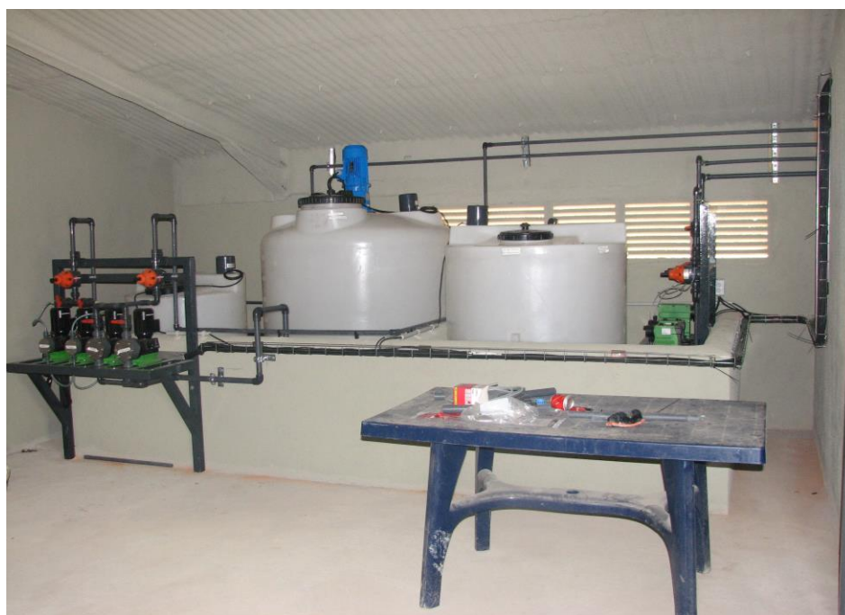
Hệ thống lọc cát và pha hóa chất
